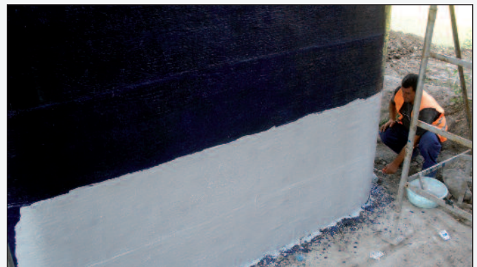
Figure 6A, 6B e 6C - Le fasi dell'intervento.
